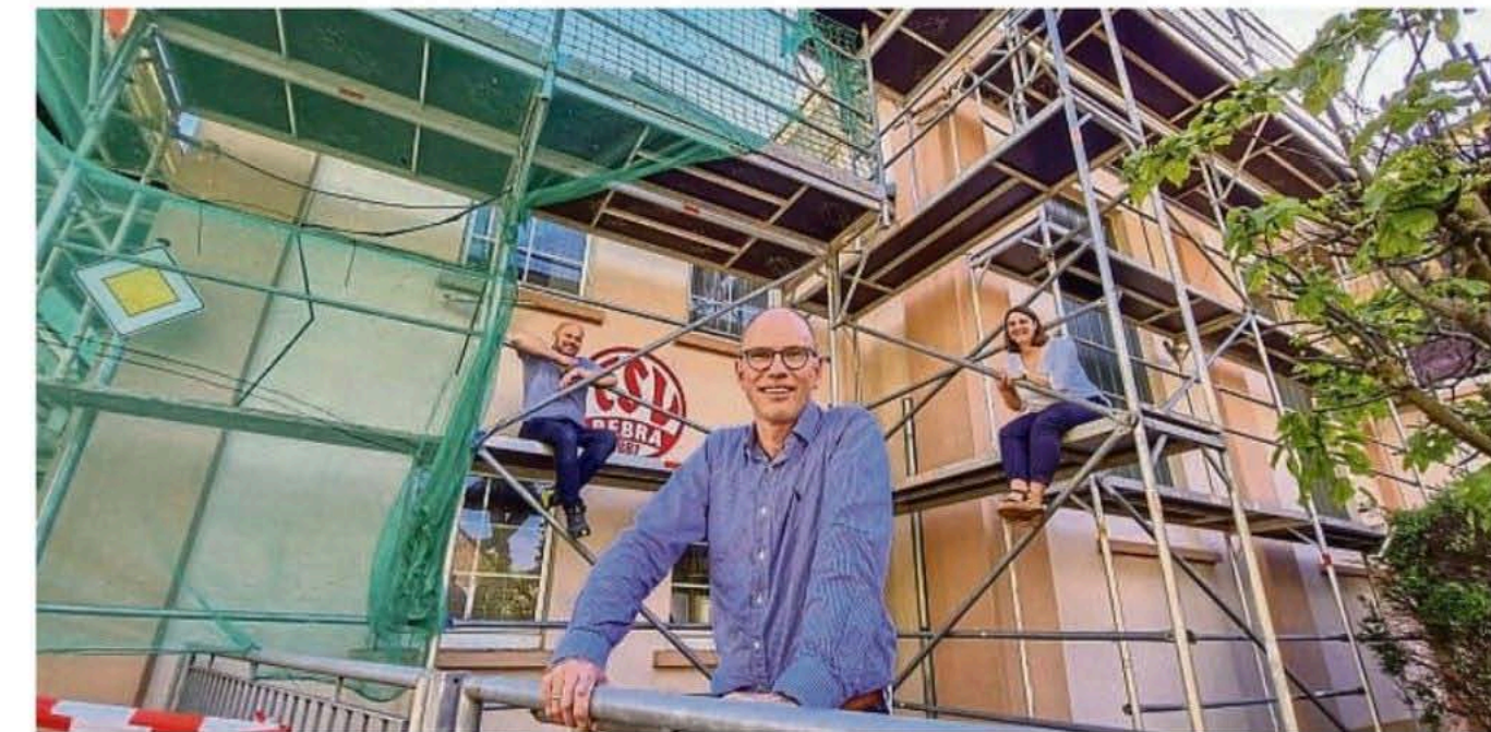
Eingehüllt ins Baugerüst: Das Ziegeldach der Sporthalle des TSV Bebra wird derzeit komplett saniert. Unser Foto zeigt – von links – Gebäudewart Jörg Lingelbach, Thilo Holzhauer und Johanna Schmauch.
